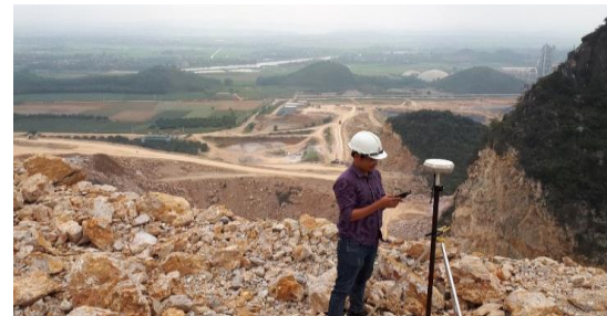
Hình 4. Công tác đo GNSS-RTK thực địa.
